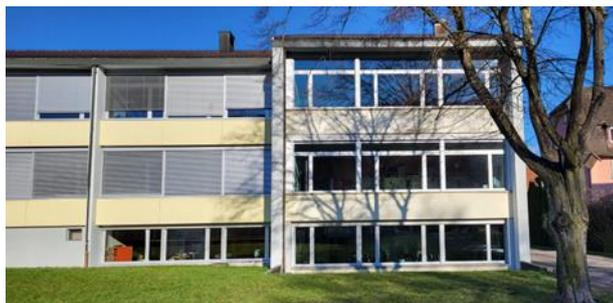
Über die nach Süden ausgerichtete verglaste Fassade gelangt viel Wärmeenergie in das Gebäude. Im Zuge der Fenstererneuerung kommt eine neutrale Sonnenschutzverglasung zum Tragen, die den Wärmeeintrag in den Sommermonaten um ca. 50% reduziert.
